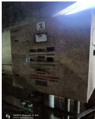
รูปถ่ายที่ 3.2-32 : อุปกรณ์ไฟฟ้าชนิดป้องกันการระเบิด (Explosion proof)
