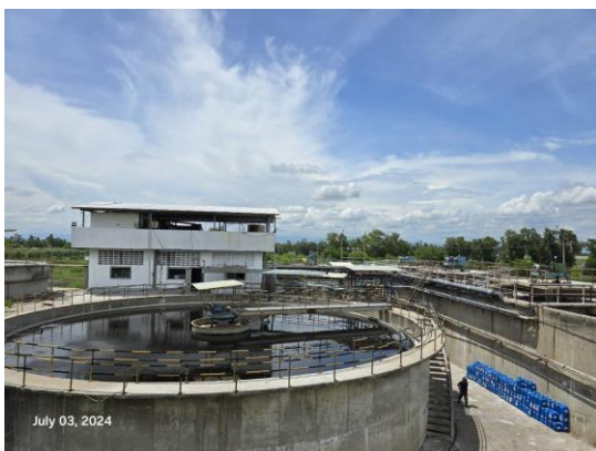
รูปถ่ายที่ 3.2-19 : ระบบบำบัดน้ำเสียแบบเติมอากาศ (AS)
