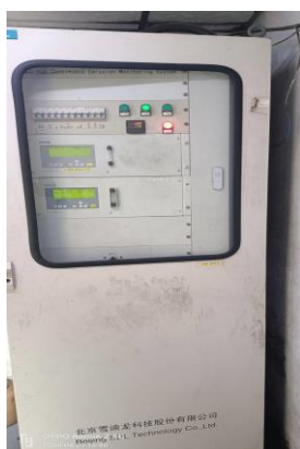
รูปถ่ายที่ 3.2-5 : ระบบตรวจวัดคุณภาพอากาศแบบต่อเนื่อง (CEMs) ปล่องระบายของหม้อไอน้ำขนาด 35 ตัน/ชม.
