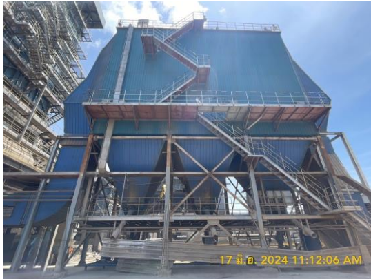
รูปถ่ายที่ 3.2-1 : ระบบดักฝุ่นละอองแบบไฟฟ้าสถิต (ESP) ของหม้อไอน้ำ ขนาด 35 ตัน/ชั่วโมง
