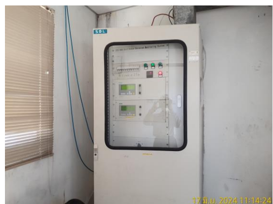
รูปถ่ายที่ 3.2-6 : ระบบตรวจวัดคุณภาพอากาศแบบต่อเนื่อง (CEMs) ปล่องระบายของหม้อไอน้ำขนาด 75 ตัน/ชม.
